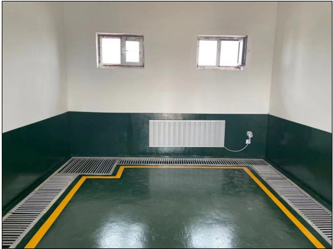
图4-2 危废间内防渗
